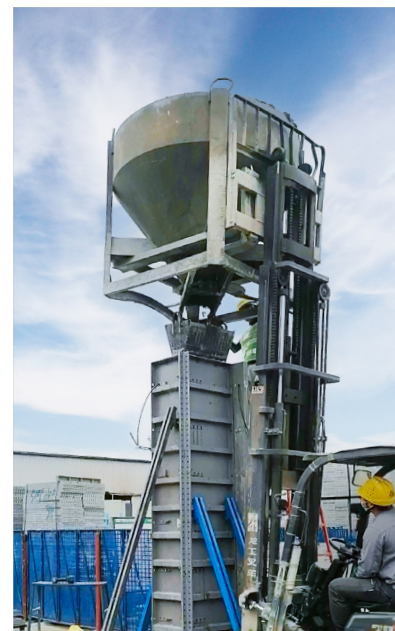
Concrete Pouring / 浇筑图
